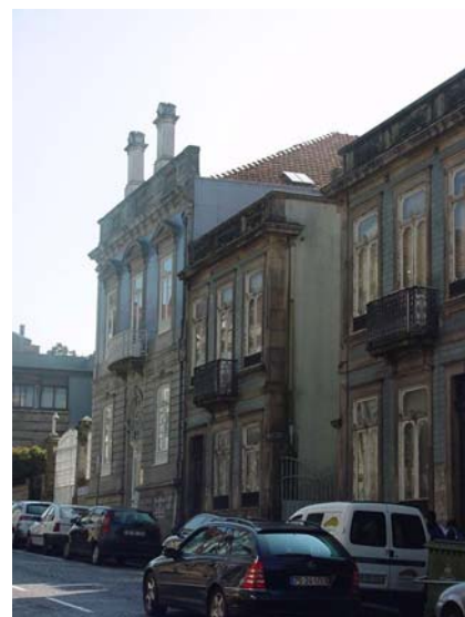
Fachada das instalações da Nova Sede da OASRN
