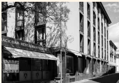
2 Centro Comercial e Clínica da Sé (antigo aparthotel Guilloteau)
