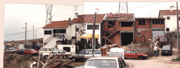
Foto de edificação de tipologia da Fase 3
