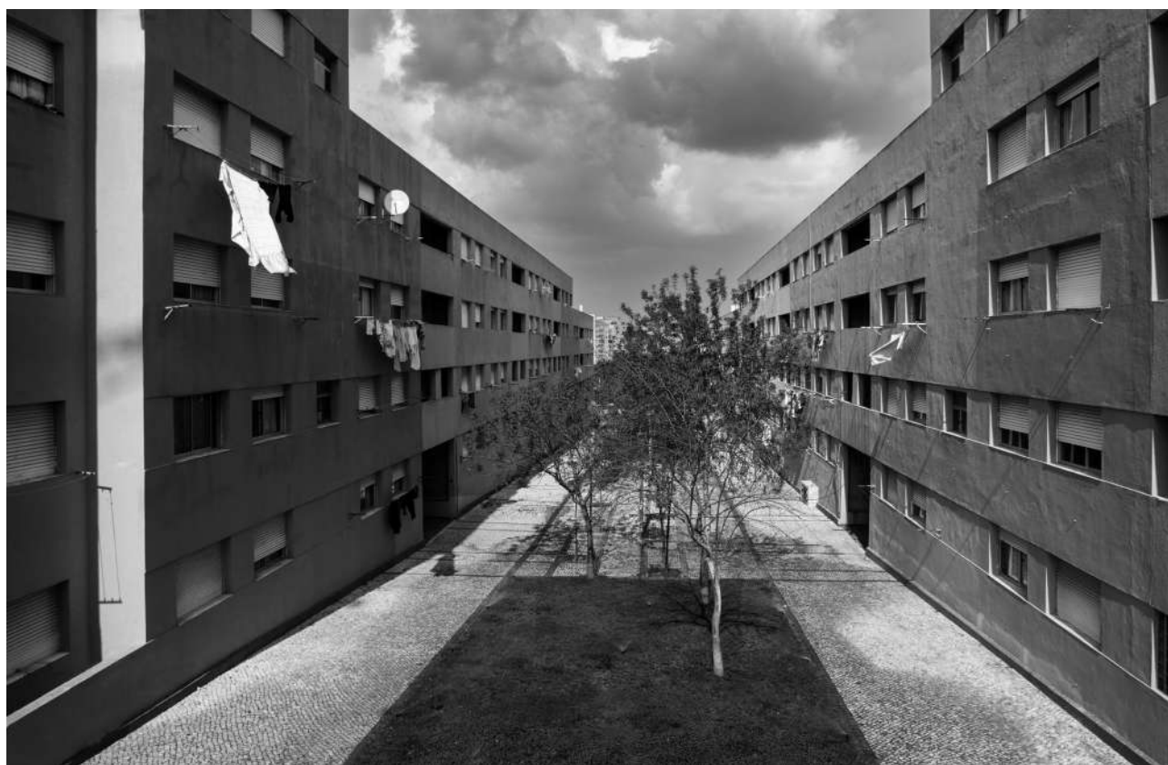
Conjunto Habitacional da Praça de Portugal (01), Setúbal. Arq. Vítor Figueiredo
