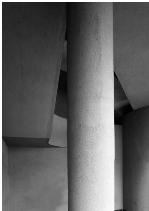
Conjunto Habitacional da Praça de Portugal (03), Setúbal. Arq. Vítor Figueiredo
