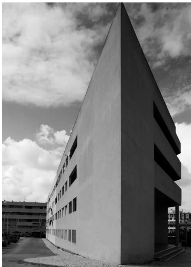
Conjunto Habitacional da Praça de Portugal (02), Setúbal. Arq. Vítor Figueiredo
