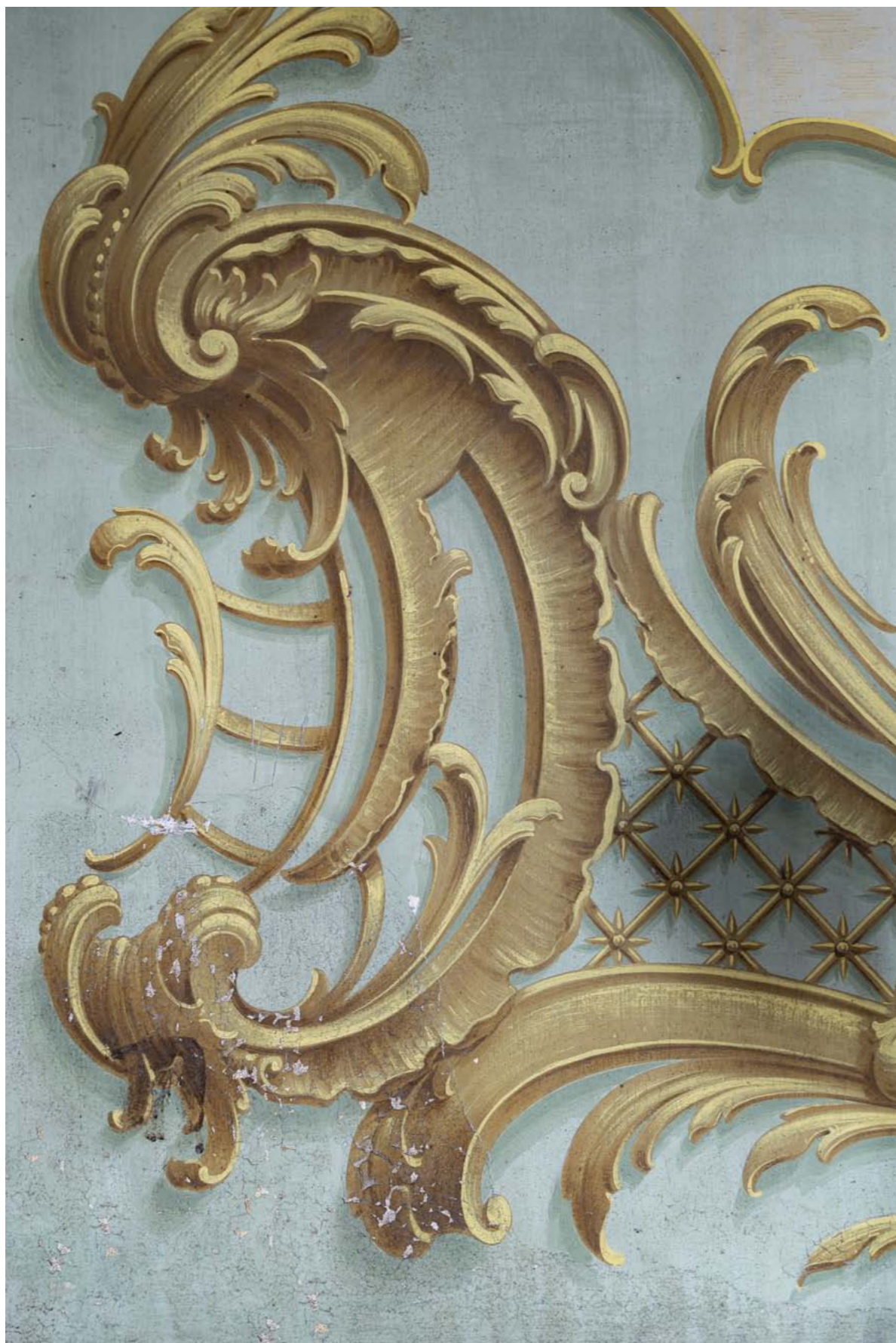
PELA LENTE DE CUNHA PIMENTEL - EM OBRA
