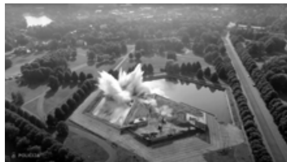
Antes e durante a demolição do Monumento aos Libertadores de Riga e da Letônia Soviética dos Invasores Fascistas Alemães. Fotos: Valsts Policija, 2022
