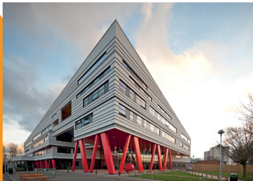
Andrew Marvell College, Kingston Upon Hull, Reino Unido. Sistemas utilizados: MB-59S Casement, MB-78EI, MB-SR50
