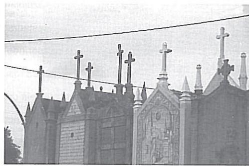
Fot. 7 - O costume importado do Brasil de revestimento exterior atingiu em Portugal as fachadas menos esperadas (Cemitério de Esmoriz)
