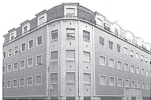
Fot. 8 - A primeira tentativa de reutilização de azulejo em fachadas, na época moderna, deve-se a Pardal Monteiro (Edifício da Rua Val do Pereiro, em Lisboa)
