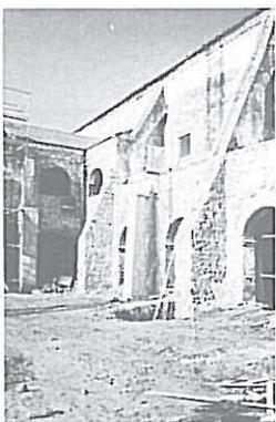
Fig. 19 - Reforço de contrafortes e arcobotantes.
