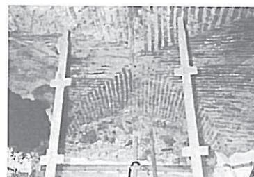
Fig. 20 - Início do processo de reforço de uma abóbada - Chagas.
