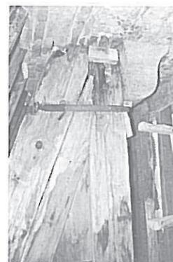
Fig. 24 - Apoio de asna de madeira antes da intervenção com argamassas de resina epoxy.
