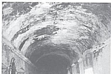
Fig. 17 - Abatimento de abóbada de asa de cesto associada a fendilhação longitudinal.
