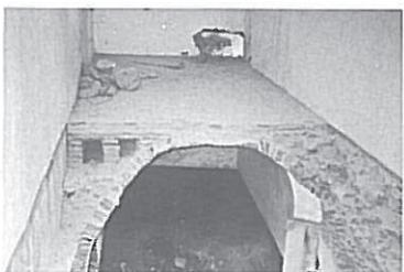
Fig. 11 - Carregos de abóbada aliviado com elementos de alvenaria - Chagas.
