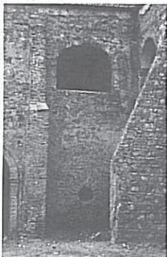
Fig. 4 - Contrafortes de alvenaria ordinária e de tijolo lambaz.
