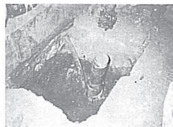
Fig. 7 - Cabeça de micro-estaca.
