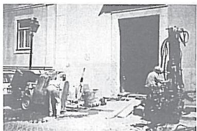
Fig. 5 - Execução de micro-estacas: furação.
