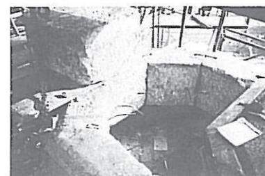
Fig. 7 - Consolidação do topo do pedestal. Solidarização das cantarias da cimalha.
