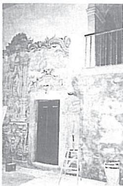
Fig. 3 - Consolidação de paredes por meio de injecções.
