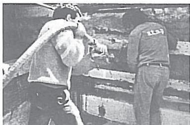
Fig. 4 - Consolidação de paredes por meio de injecções.
