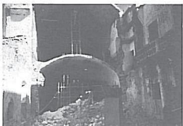
Fig. 10 - Abóbada de asa de cesto, observando-se a remoção do carregos de terra solta.
