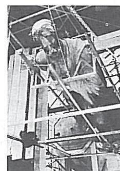
Fig. 5 - Suspensão do bronze e remoção da pedra de capeamento do pedestal.
