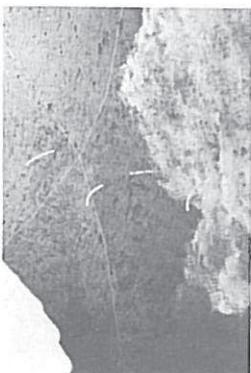
Fig. 21 - Preparação da injeção de paredes de abóbadas, mostrando os tubos de injeção.
