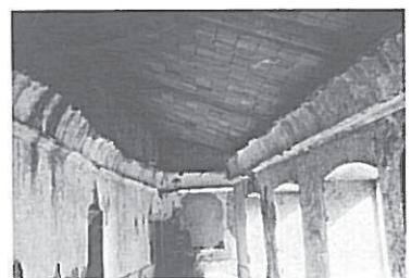
Fig. 26 - Cobertura com "laje de vigotas", vendo-se ainda as nascentes das abóbadas pré-existentes.
