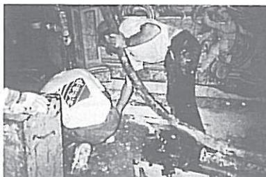
Fig. 6 - Execução de micro-estacas: injecção.
