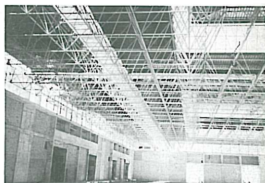
11 – Estrutura espacial pré-fabricada com perfis tubulares
