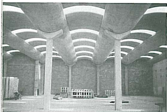
8 – Cascas HP pré-esforçadas sobre pilares com "berço"
