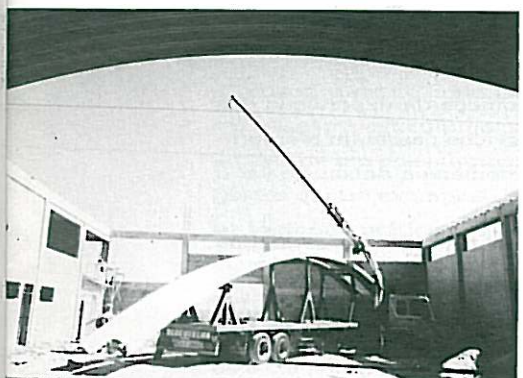
17 – Cascalas metálicas de perfil curvilíneo complexo
