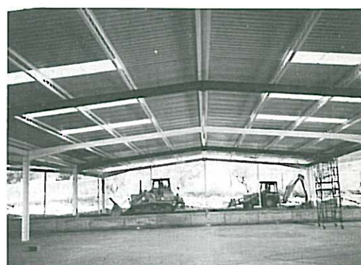
10 – Pórticos de aço a partir de perfis IPE, com recurso a ligações aparafusadas
