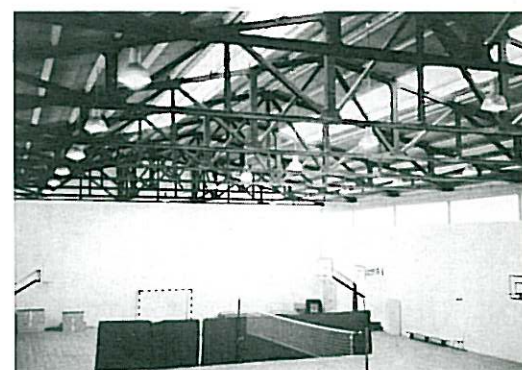
4 – Asnas de betão: apenas o amaciamento de alguns nós permite perceber, com clareza, que não se trata de asnas de madeira
