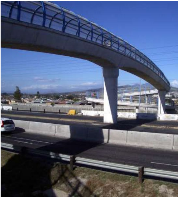
Figura 2.22 Passagem de peões superior com rampa (Foto: Cardoso, J. L.)
