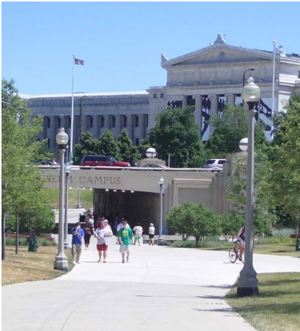
Figura 2.23 Passagem de peões inferior a arruamento com múltiplas vias (Foto: Cardoso, J. L.)
