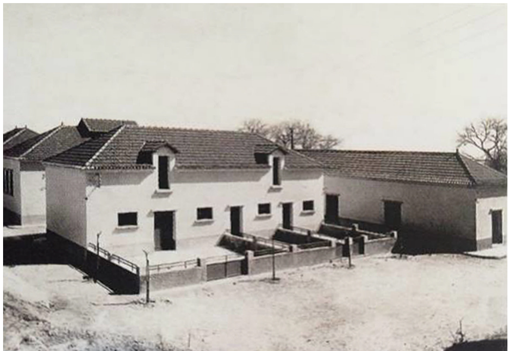
Figura 2 Matadouro em construção, 1938-1940 2
