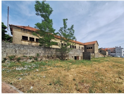
■ ■ Figuras 17 e 18 Vista geral a sul
