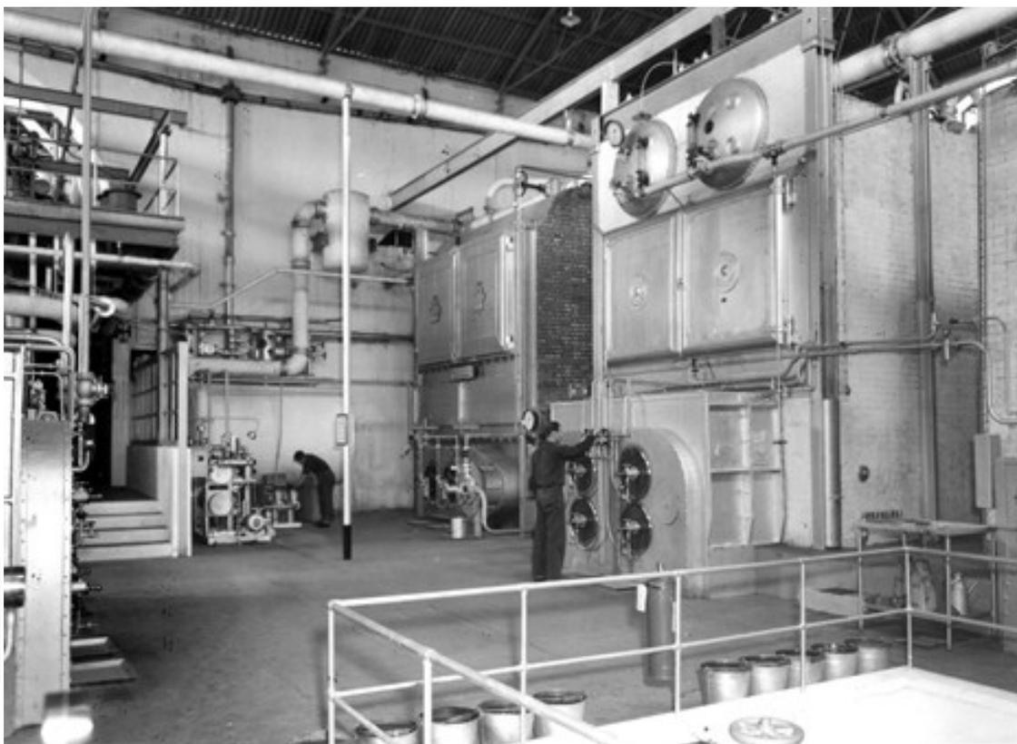
**Figura 16 – Sala das Geradoras de vapor “Babcock & Wilcox”.**
